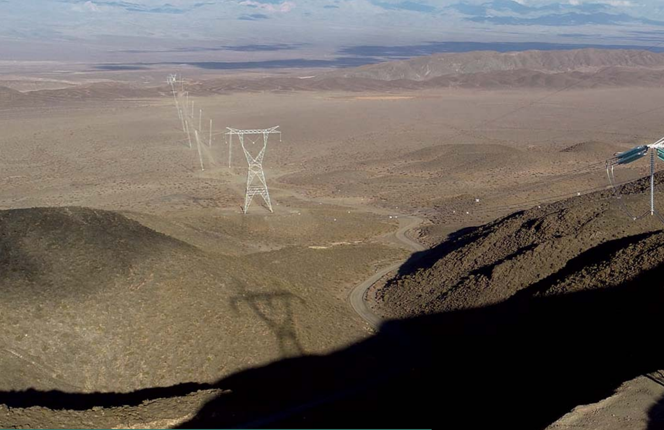
Línea de Extra Alta Tensión San Juan – Rodeo / Iglesia. Entró en Servicio el 27 de Junio de 2021
