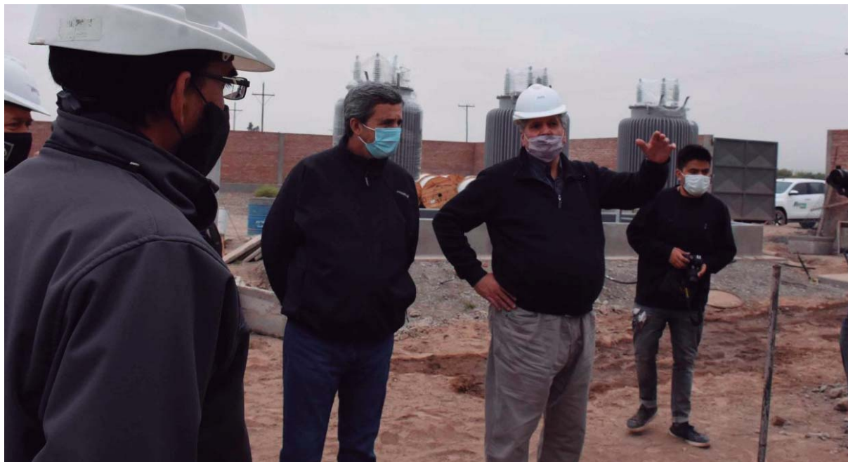
Inspección de las Obras ET Pampa del Chañar - Jáchal
